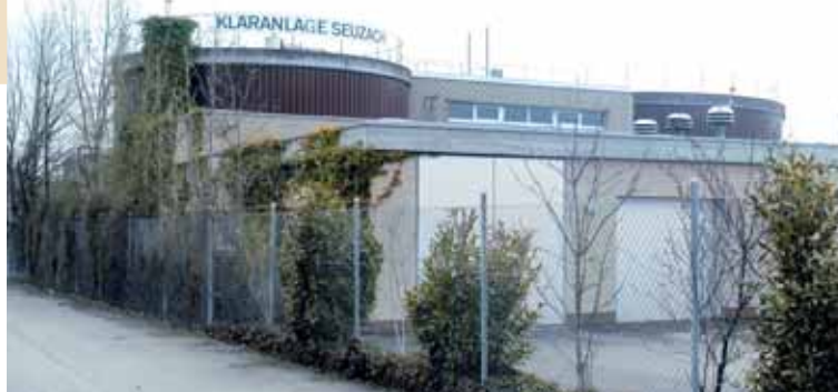
Ausbau/Erweiterung Kläranlage, 8472 Seuzach
