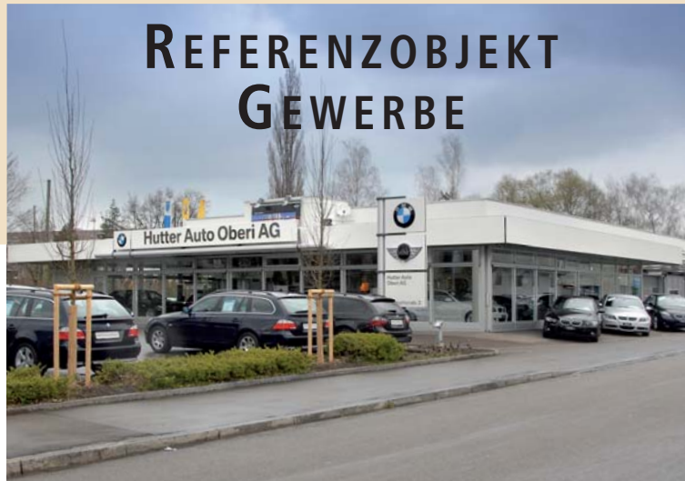
Umbau Oberi-Auto AG BMW, Frauenfelderstr. 9, Winterthur
