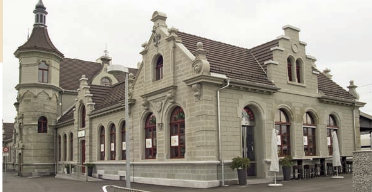
Sanierung und Umbau SBB Bahnhof, Rapperswil
