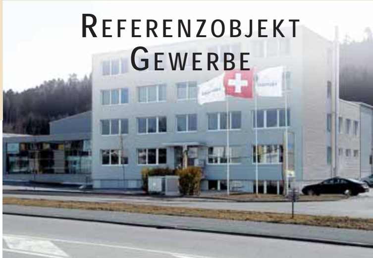
Werk- und Bürogebäude Frutiger Baumaschinen, Winterthur
