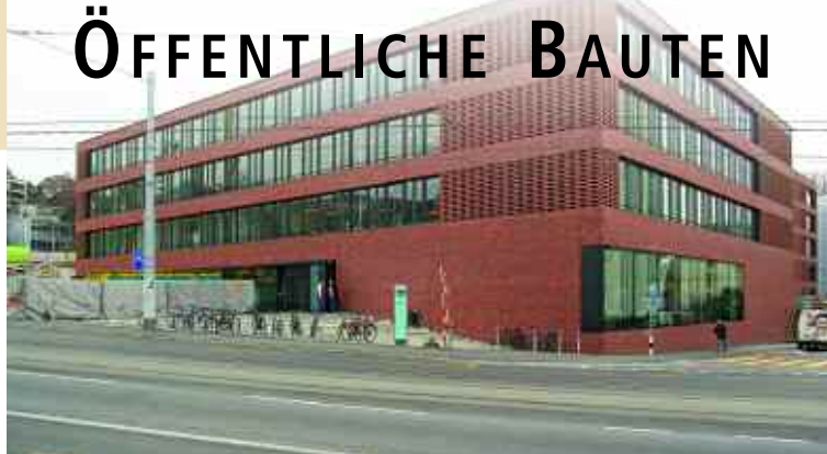
Careum-Areal, Zürich, 1. Etappe
