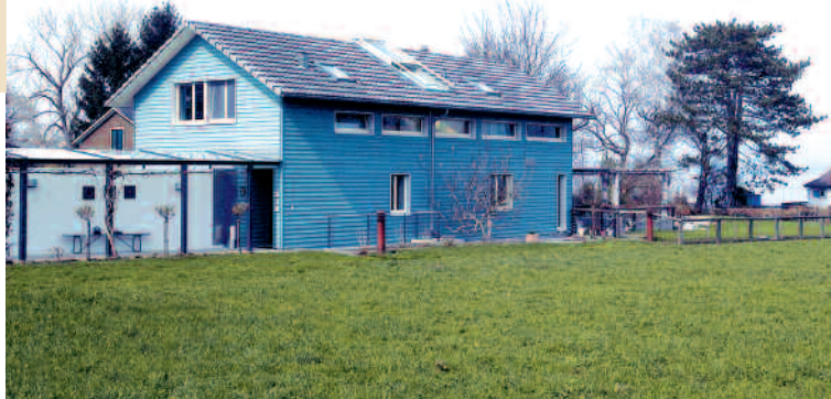
Einfamilienhaus am Bodensee, 8593 Kesswil
