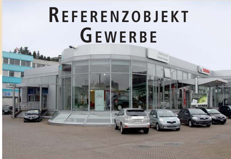
Umbau Emil Frey Grüze Garage, Winterthur
