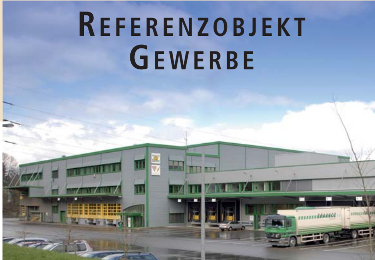
Erweiterung FENACO-Niderfeld Logistikgebäude, Winterthur
