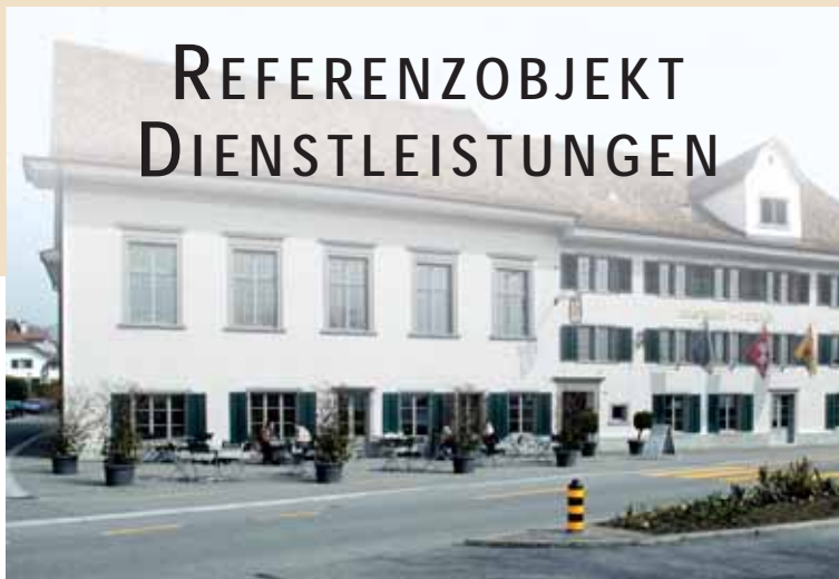
Umbau und Sanierung Gasthof Löwen, 8706 Meilen
