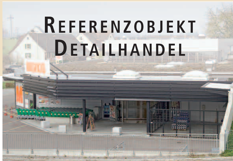
Grundausbau und Mieterausbau Migros-Markt Eglisau
