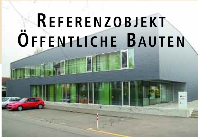
Neubau Werkgebäude, Wiesendangen
