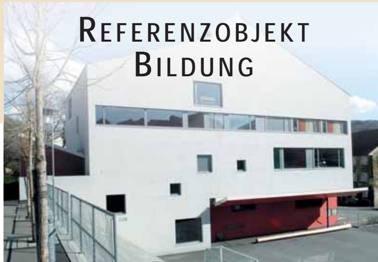
Neubau Primarschulhaus mit Kindergarten und Wohnung in Eglisau
