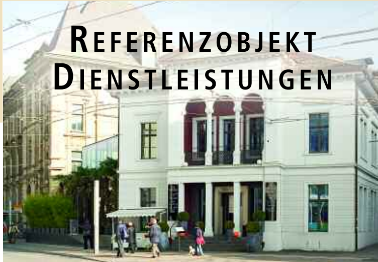
Restaurant «National», Stadthausstrasse 2, Winterthur
