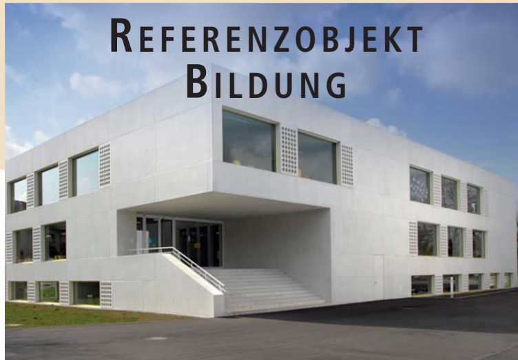
Neubau und Umbau Schulanlage Steinmürli, Dietikon
