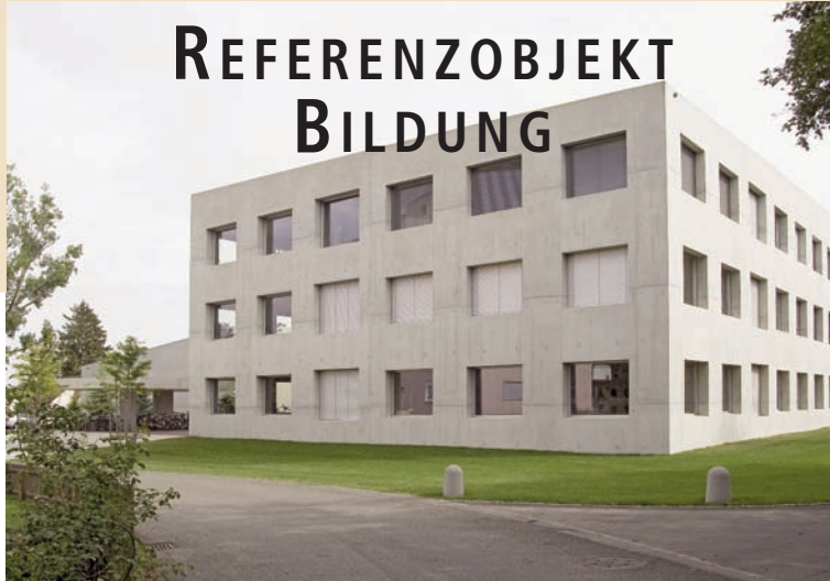
Sanierung und Erweiterung Sekundarschulzentrum, Tägerwil
