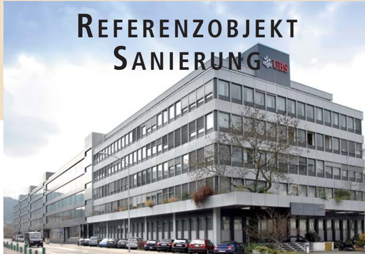
Sanierung UBS-Flurhof, Zürich
