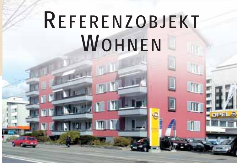
Umbau Badenerstrasse 444 / 446, Zürich
