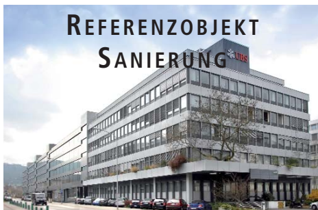
REFERENZOBJEKT SANIERUNG Sanierung UBS-Flurhof, Zürich
