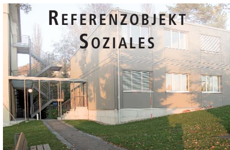
REFERENZOBJEKT SOZIALES Bettenhaus Neubau und Umbau Akutspital Bezirksspital, Affoltern am Albis
